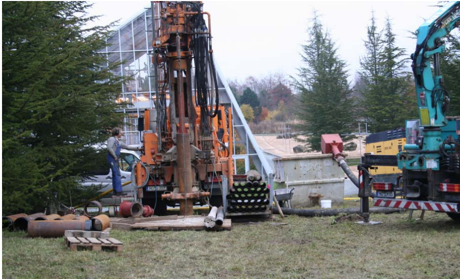
Abb. 10: Bohrung eines Tiefbrunnens für die Nutzung von Grundwasser im ÖBG (November 2011).
