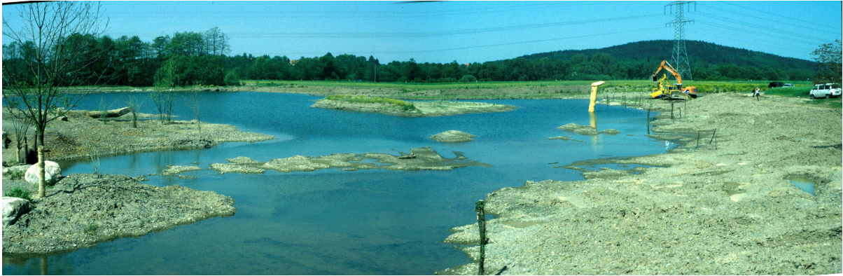
Abb. 2.12: Nach der Renaturierung eines Fließgewässers mit schweren Maschinen übernimmt die Flussdynamik die weitere Entwicklung der Uferbereiche (Renaturierungsfläche bei Redwitz an der Rodach im April 1999).
