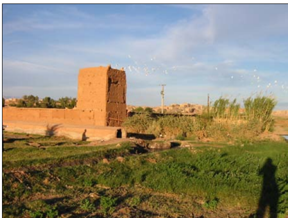
Foto 35: Hauptauslassstelle des städtischen Abwassernetzes
