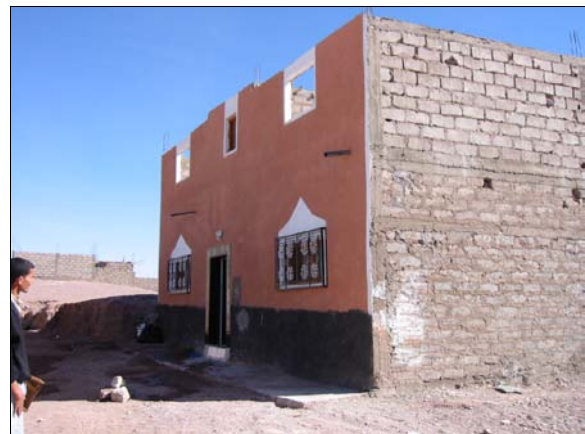
Foto 40: Neubau in der informellen Siedlung
