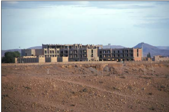
Im Bau befindliche Hotelanlage
