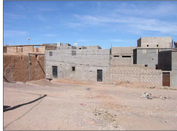
Foto 62: Wassertanks auf den Hausdächern in Tamassinte
