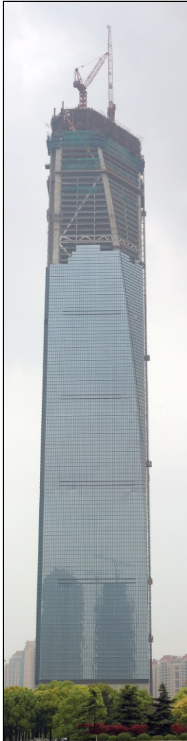
Abbildung 2-21: Shanghai World Financial Center, Bauzustand
