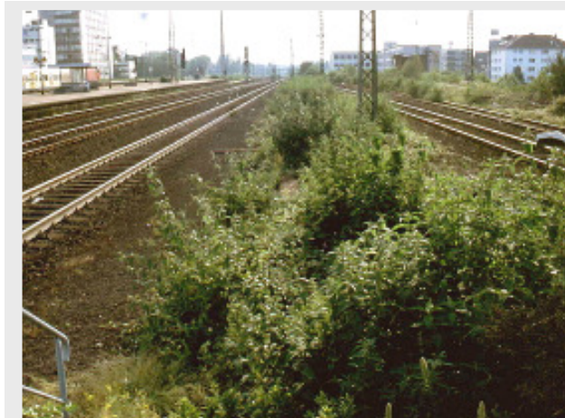
Abb. 44: Blick vom Westende des Bahnsteigs 1 (zw. Gleis 1 und 2) auf die offene Strecke (Mitte Juni). Bahnsteig 2 (links) ist deutlich länger, allerdings wird der gezeigte Abschnitt praktisch nicht benutzt.
