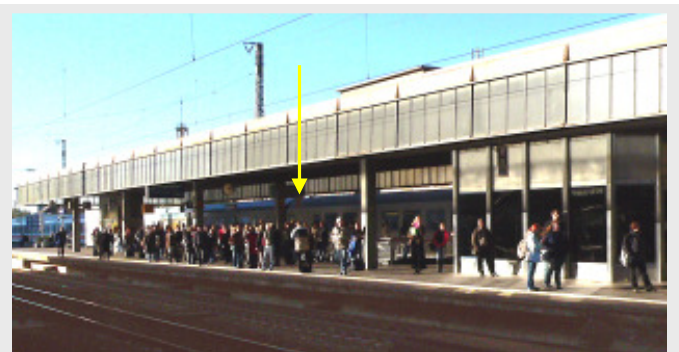
Abb. 42: Gleis 2 an Bahnsteig 1, der Pfeil markiert die Lage des obersten Absatzes des westlichen zentralen Treppenaufgangs (vgl. Abb. 3).
