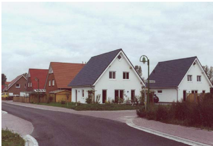
Abbildung 31 : Neubausiedlung bei Oldenburg Unmotivierte Strassenräume und gewohnte Gebäudekubaturen
