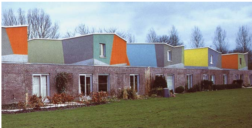
Abbildung 50: Reihenhäuser in Groningen Gestaltungsprinzip: Sockel/ EG + flexible Aufstockung
