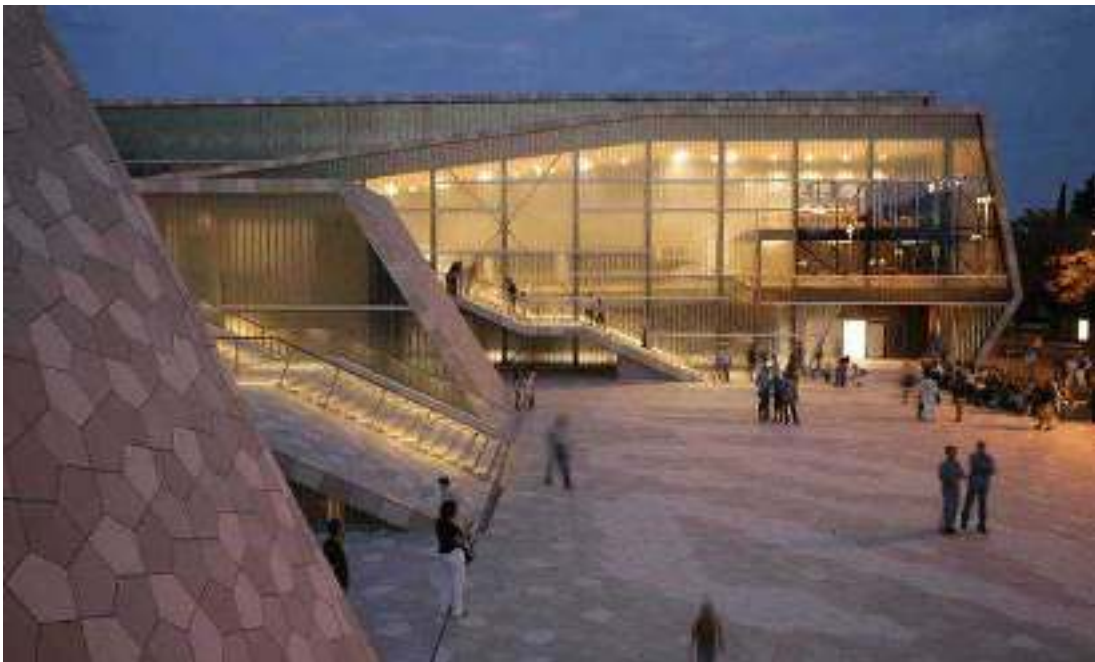
Figura 50: Fachada del Centro Zamet - Norte.
