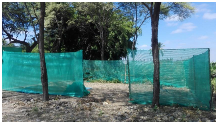
Figura 03: Construcción del área experimental
