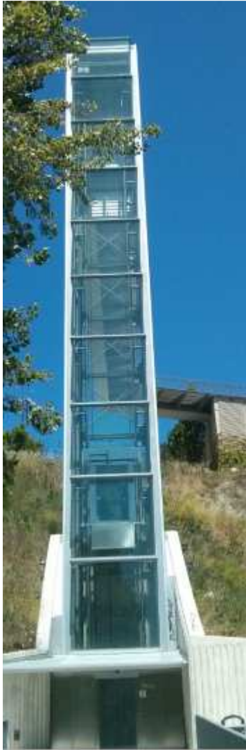
Ascensor que une Etxabakoitz norte y Etxabakoitz sur.
