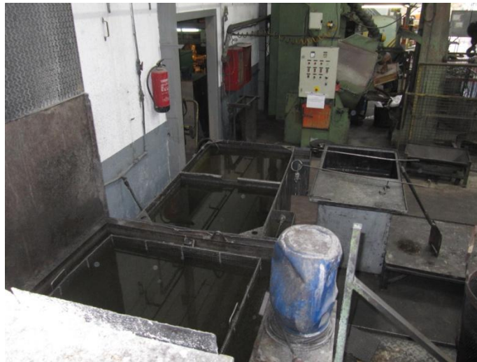
Fig 3.2-6. Cascada de enfriamiento/lavado-VTN.
