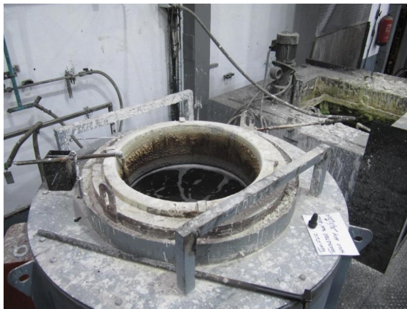
Fig 3.2-4. Baño de nitrocarburación TF 1-VTN.
