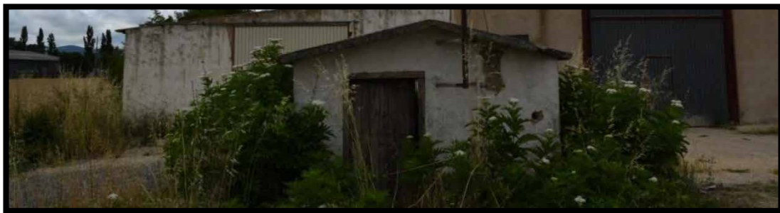
Ilustración 14: Vieja caseta que alberga el pozo en su interior
