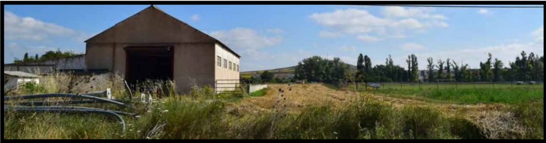
Ilustración 7: Vista desde los vértices SE exterior e interior de la parcela
