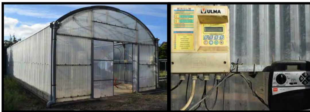
Ilustración 15 y 16 Invernadero y detalle de equipo de automatismos.
