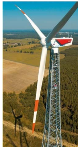
Figura 4.8: Aerogenerador con estructura de celosía
