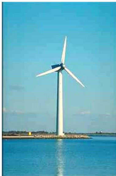
Figura 4.9: Aerogenerador con estructura tubular
