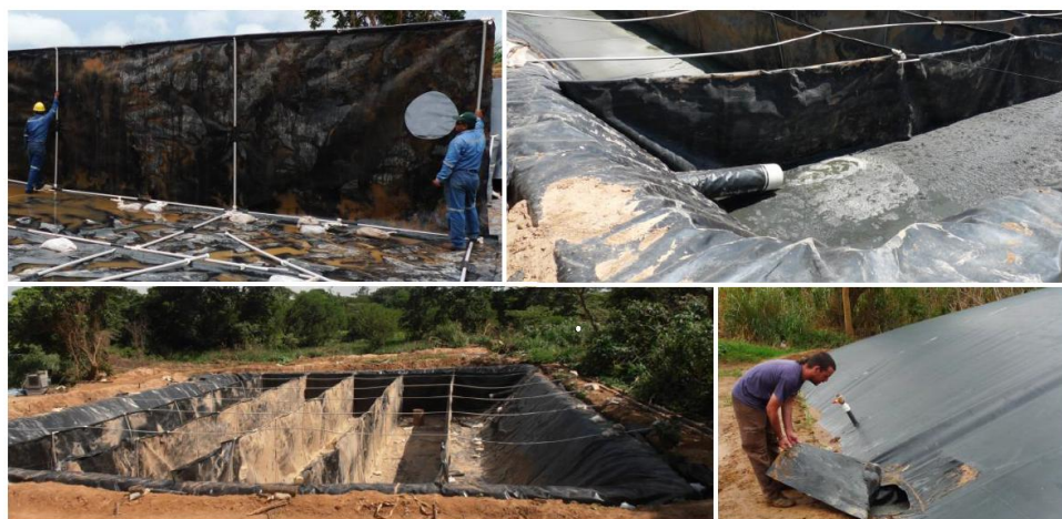
Figura 46: Construcción de un biodigestor de 1000m 3 . Fuente: Construcción de un biodigestor de laguna cubierta con recorrido eficiente, J.Martí Herrero
