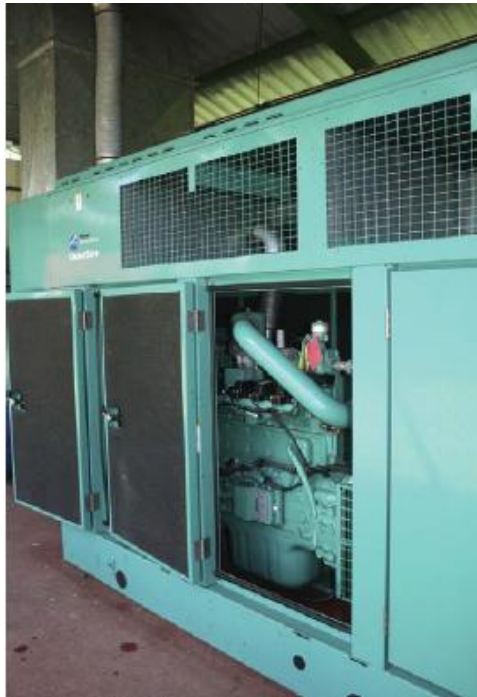
Figura 82: Motor de encendido provocado a gas natural modificado para operar con biogás. Fuente: Escuela de Agricultura de la Región Tropical Húmeda
