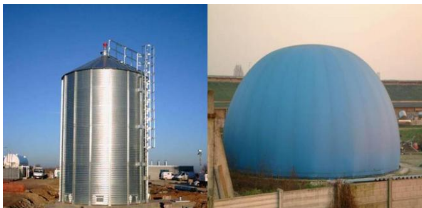
Figura 53: Ejemplo de depósitos de biogás fabricados en distintos materiales. Fuente: AQL engineering
