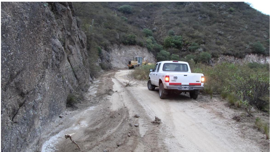
Figura II.4.23: Caída de rocas en la cuesta de Capillitas.
