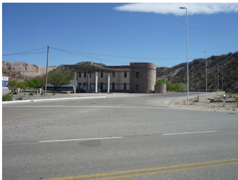
Figura II.10.20: Cruce ruta nacional 40 y ruta provincial 46.
