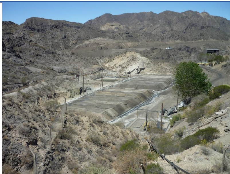
Figura III.1.11: Pilas de lixiviación de Farallón Negro.
