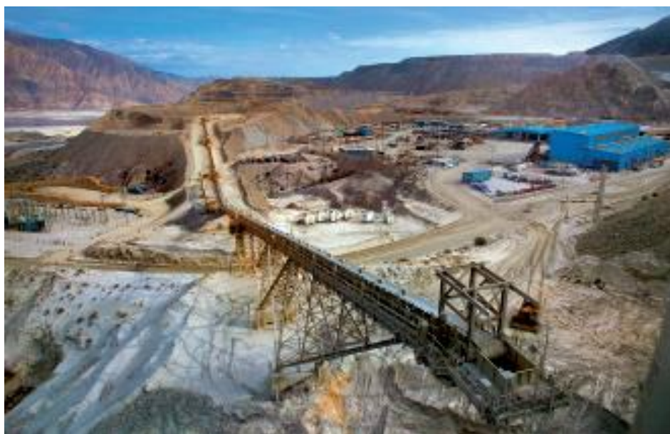
Figura III.1.4: Planta de tratamiento de Mina Alumbraera.
