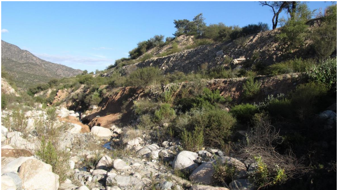
Figura II.4.9: Profundización del cauce del arroyo La Cañada.
