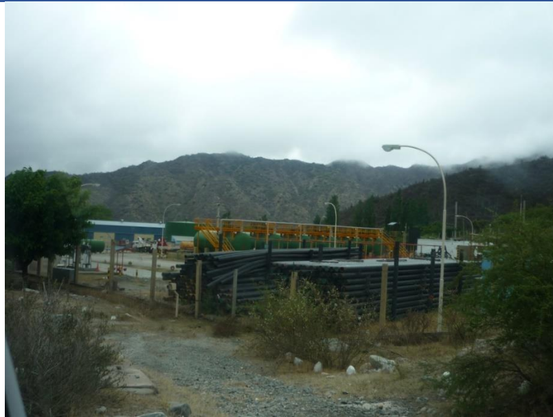
Figura II.10.17: Mineraloducto. Planta de bombeo – Villa Vil.
