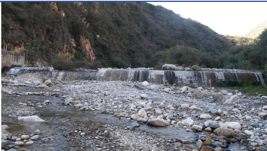
Figura II.4.10: Toma de agua en el río Andalgalá.
