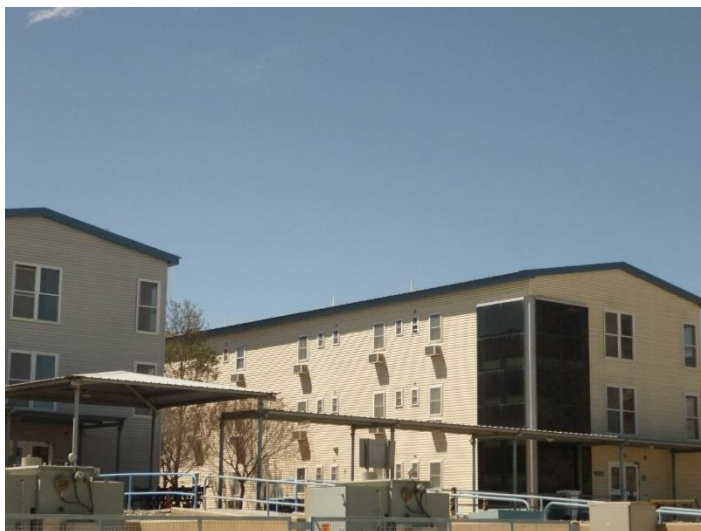
Figura II.10.16: Área de administración de la empresa.
