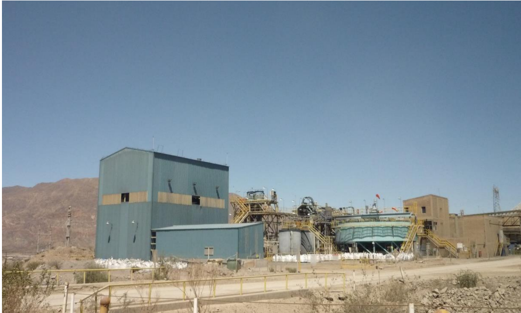
Figura III.1.6: Vista de la planta de tratamiento.
