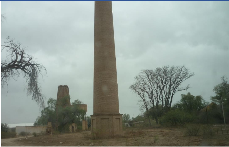
Figura IV.2.1: Locación de una fundición en Pícao.
