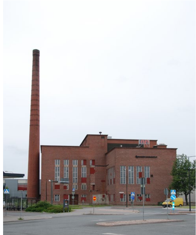
Kuva 13: Paloheimon vanha voimalaitos on keskeinen osa aseman ympäristöä, mutta rakennukseen ei ole vakiintunut uutta käyttöä voimalatoiminnan loputtua.
