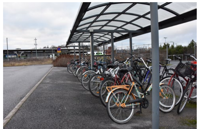
Kuva 19: Pyörien liityntäpysäköintiä asematunnelin Peltosaaren puoleisen sisäänkäynnin tuntumassa.
