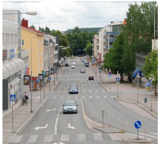
Kuva 10: Katuympäristö Keskuskadulla on autoliikennepainotteista, eikä se tue katuelämän muodostumista.
