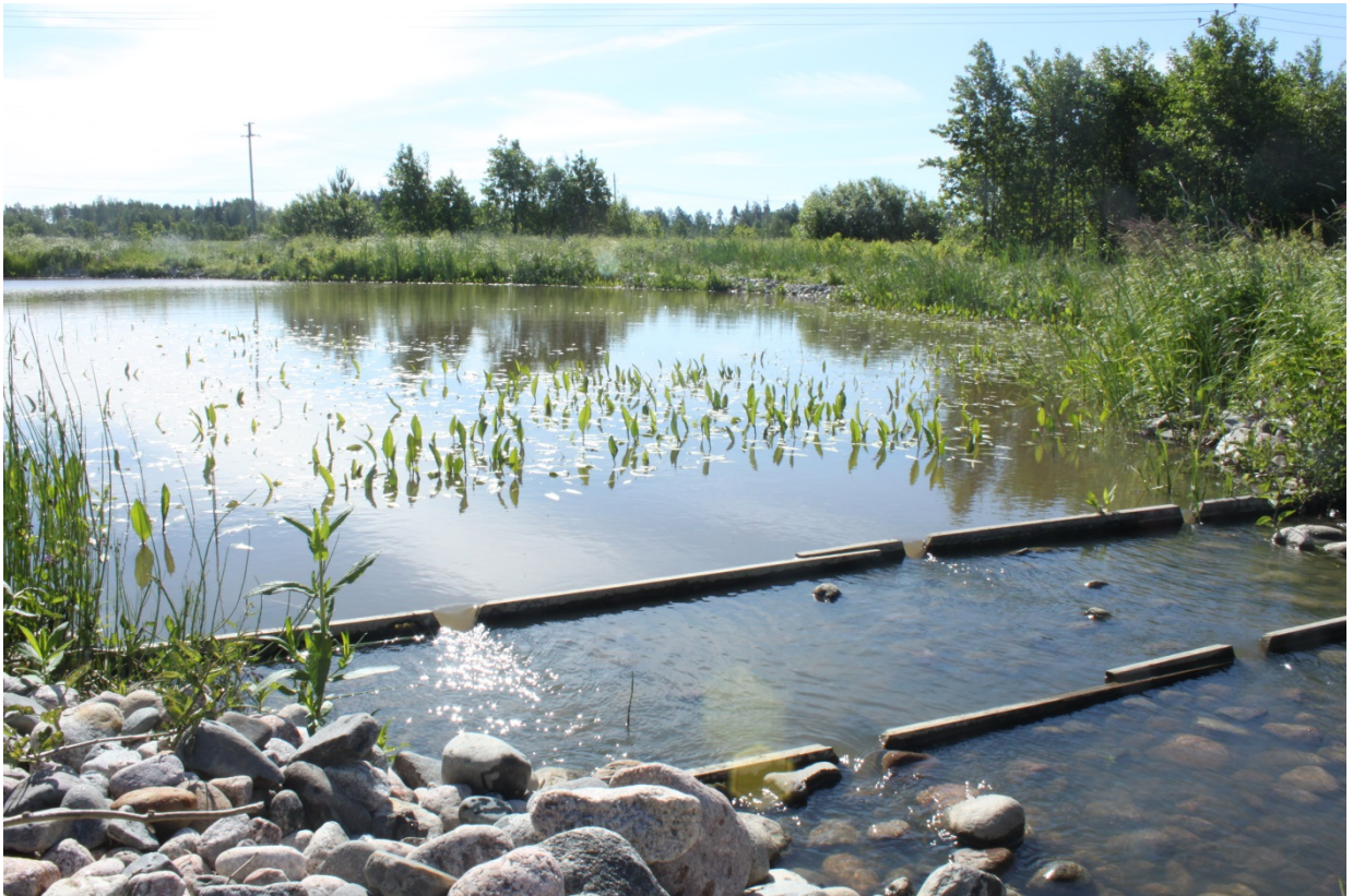
Hulevesien käsittelemiseksi rakennettu Kulloonsillanpuron kosteikko Espoossa. Kuva: Pinja Kasvio.
