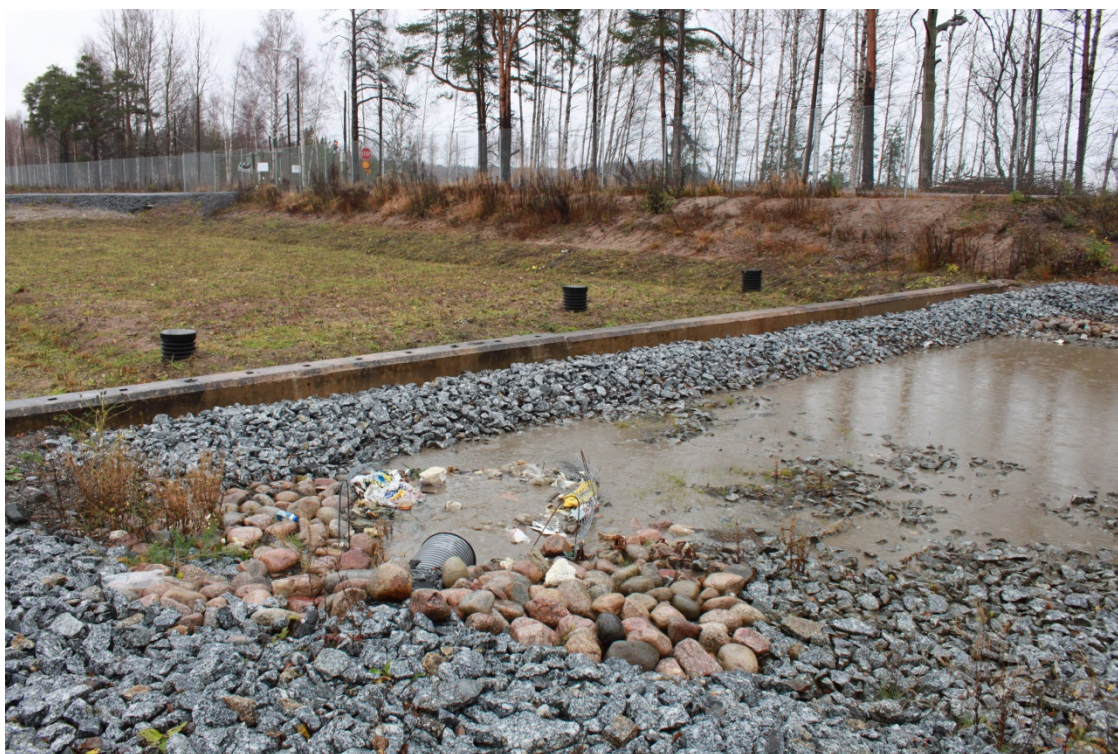
Lielahden lumenkaatopaikan biosuodatusalue. Etualalla on laskeutusallas, johon sulamisvedet ensin johdetaan purkuputken kautta. Virtauksenohjauseinän takana varsinainen suodatinkenttä. Kuva: Pinja Kasvio.
