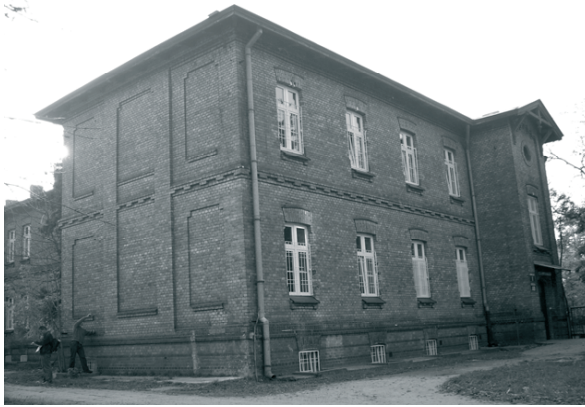
Rys. 3. Elewacja N i E obiektu – miejsce badania wilgotności muru metodą TDR.
