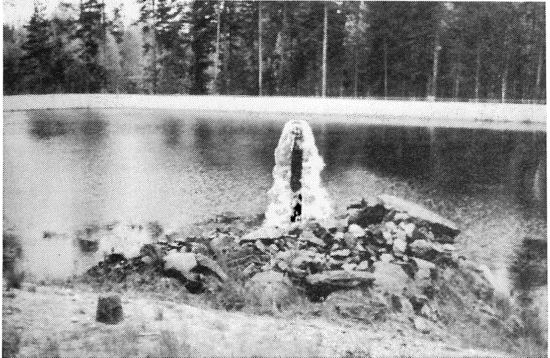
Kuva 30. Imeytysaltaat Haukkajärven laitoksella.
