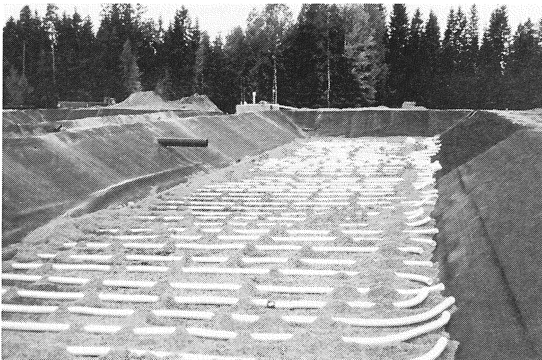
Kuva 23. Rakenteilla oleva hidassuodatusallas Tuusulan Jäniksenlinnassa.
