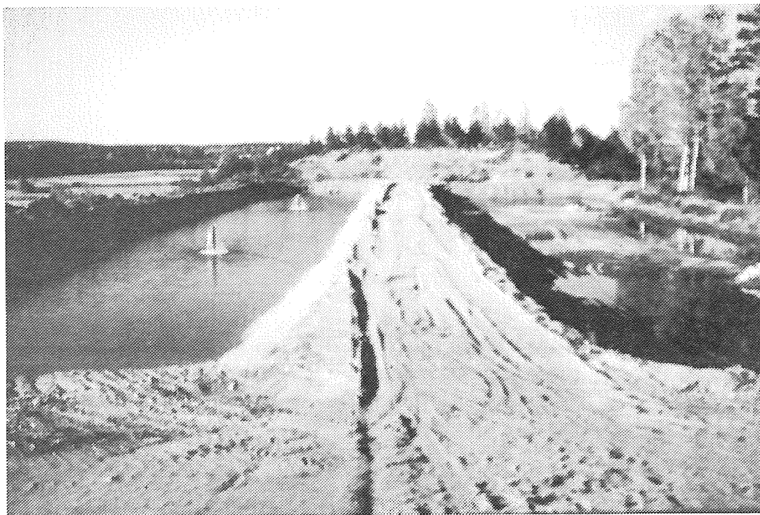
Kuva 43. Imeytysaltaat Hanhikempin laitoksella.
