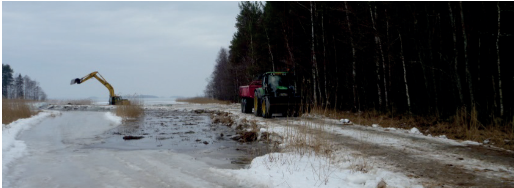
Kuva 52. Ruoppausmassoja kuljettanut traktori pääsi kulkemaan kaivinkoneelta rantaan lumesta ja jäädä tehtyä vallia pitkin.
