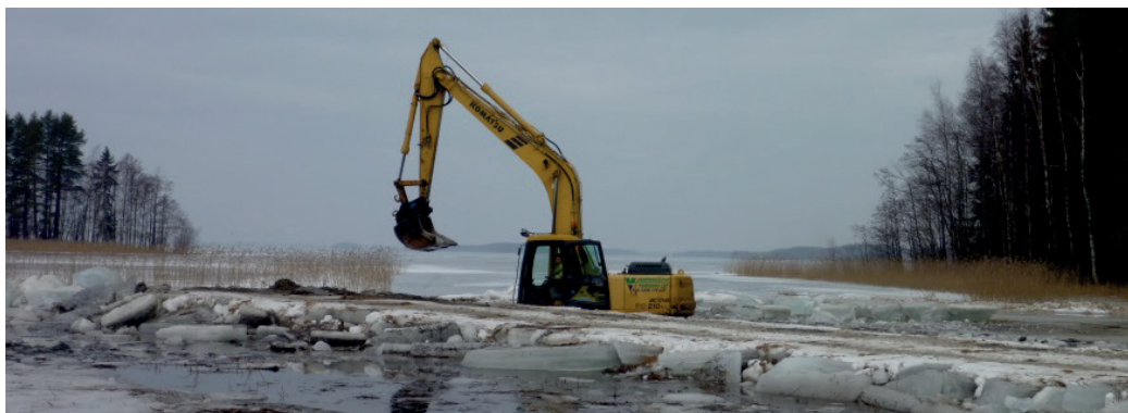
Kuva 53. Viherrakenne J. Turunen Oy:n kaivinkone työssään Likokannassa keväällä 2014.
