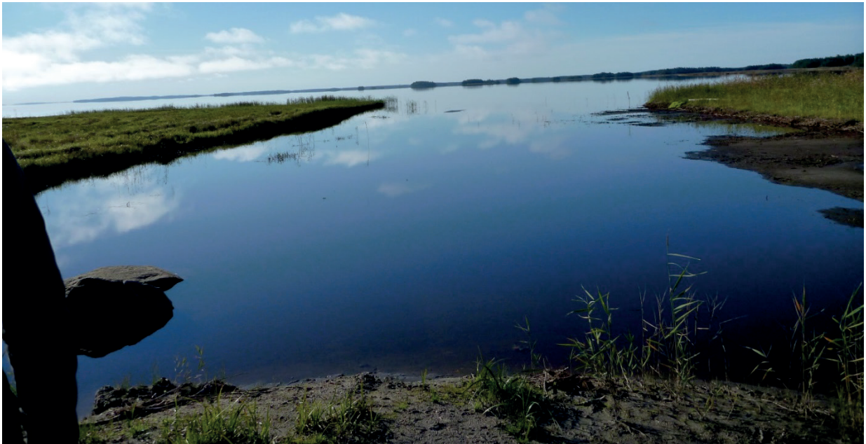
Kuva 45. Näkymä Pyhäselälle Rikinojan tuntumasta syyskuussa 2011. Laittomasti noin 20 vuotta sitten tehdyn maavallin kärki näkyy kuvan alareunassa ja alueen maatuneisuus näkyy samassa yhteydessä tehdyn veneväylän reunassa. Vedenpinnan taso oli alhainen kesällä 2011.
