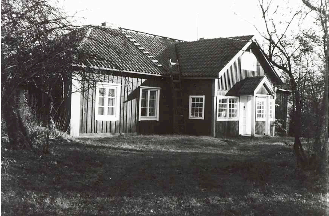
Kantakyläntie 4 1900-luvun alkupuolella. Timo Pokelan kokoelma.
