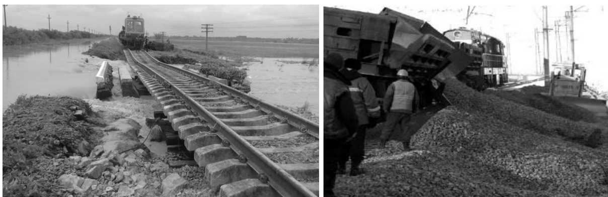
Рис. 1. Руйнування та розмив насипу залізничної колії під час паводків: а – на 224-й кілометрі перегону Заболотів – Видинів [5]; б – на 124 км дільниці Львів – Самбір – Ужгород [6]
