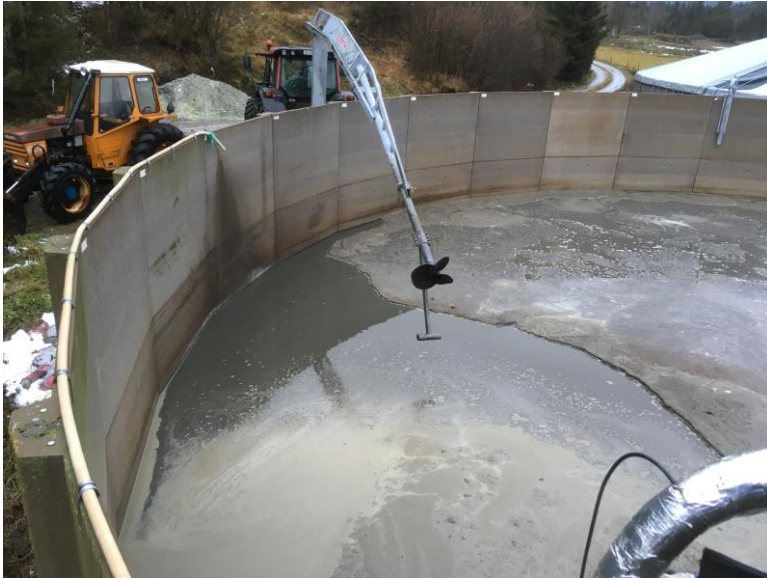
Figur 5 Gjødseltank 1 med fødepumpen og returstrømmen plassert i om lag en kvartsirkel avstand
