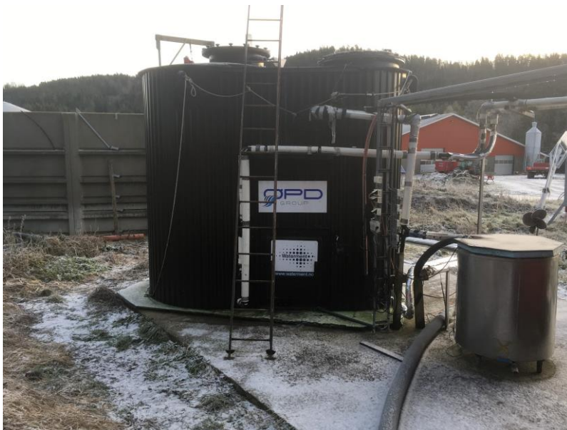
Figur 6. Biogass reaktorhus med gjødsellager i bakkant og pumpekum for retur i rustfritt stål til høyre.
