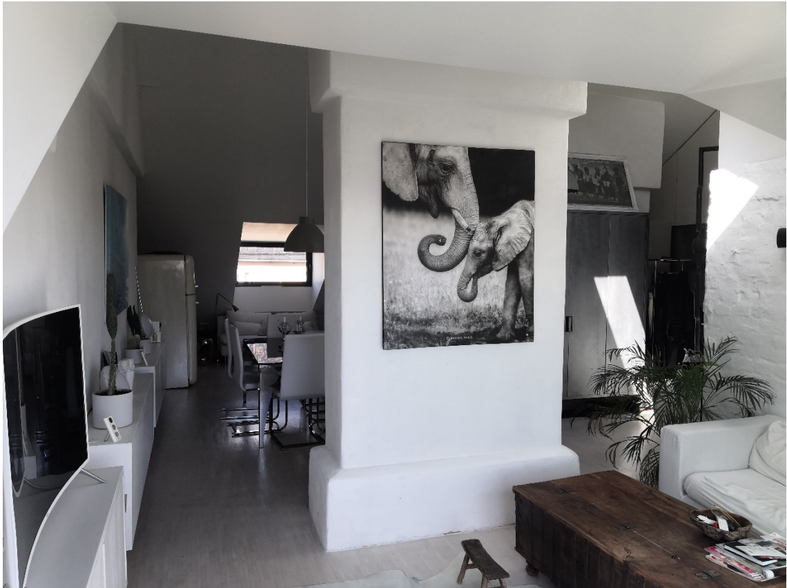
KUVA 5. Itsenäiseksi elementiksi jätetty veistoksellinen hormi on usein ullakon näyttävin yksityiskohta. Kuvan hormi toimii myös tilanjakajana oleskelutilan ja ruokailutilan välillä. Vasemmalla oleva seinä on ydinmuuri, johon suurin osa läpivienneistä on kätketty.
