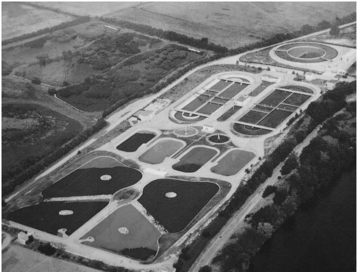
Fig. 14: Depuratore di Empuriabrava e sistema di depurazione naturale e lagunaggio. Fonte: elaborazione propria
