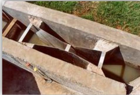
**FIGURA 7.- Medidor Parshall**
