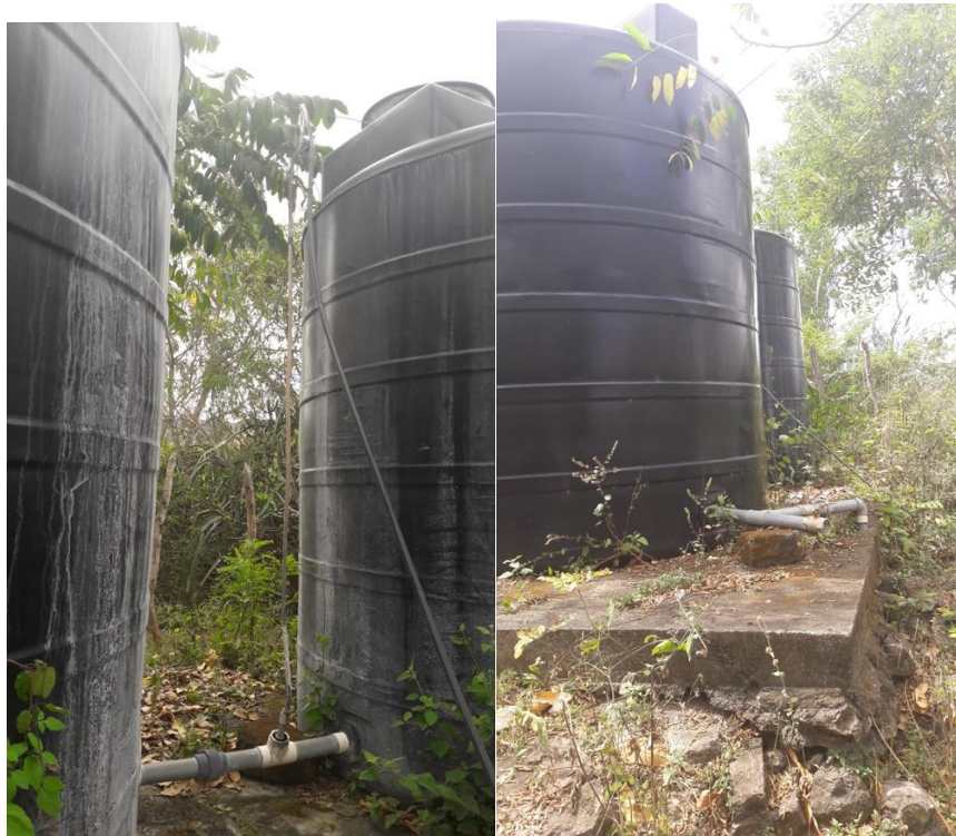
Tanques de almacenamiento
