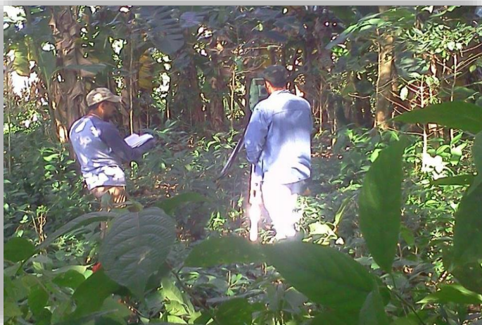
Ilustración 32. Cambio de Auxiliar en el levantamiento topográfico de la cuenca
