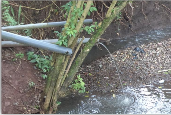
Ilustración 30. Sistemas de evacuación de A.R.D existente.
