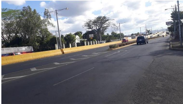
*Fotografía 43 Semáforos Nicrao con señalización horizontal en mal estado*
