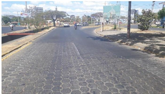
*Fotografía 41 Semáforos Villa Progreso con ausencia de señalización horizontal*
