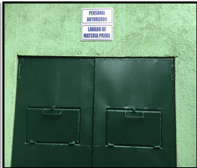
Entrada principal Área de Lavado
