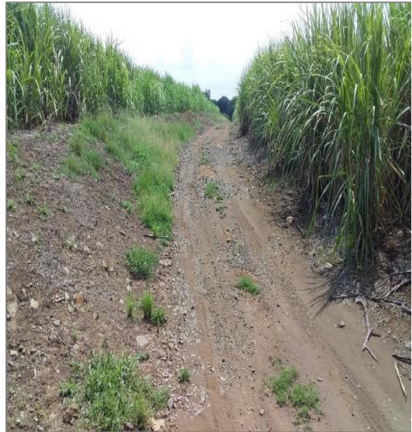
Fig. 13. Camino con material selecto
