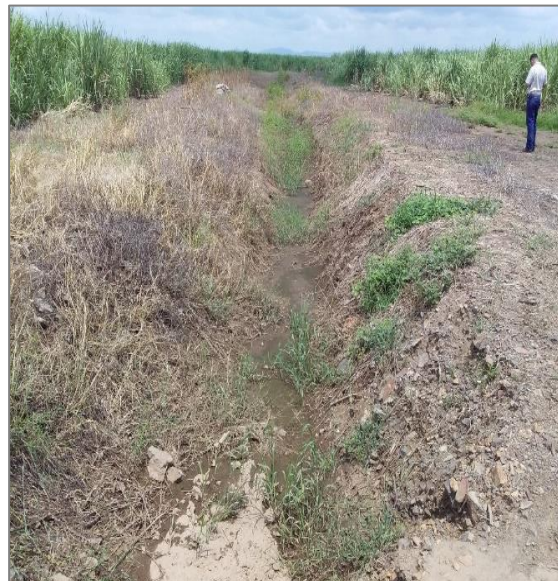
Fig. 14. Canal de drenaje
