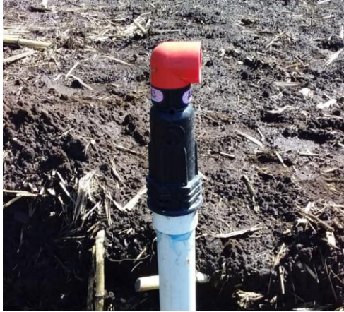
Fig. 26 Válvula doble efecto
