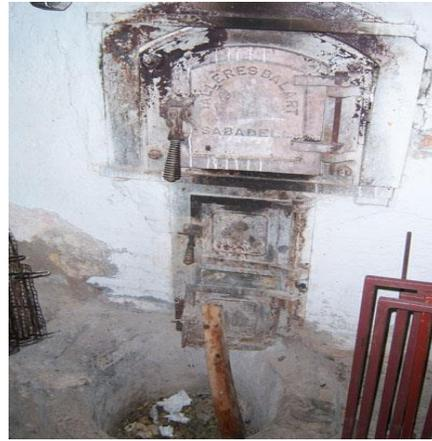
**Figura 4.** Cámaras del combustible y las cenizas
