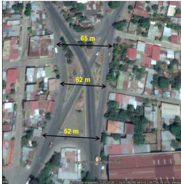
Ilustración 11. Derecho de Vía en el Empalme Tipitapa-Masaya, Estación 21+780
