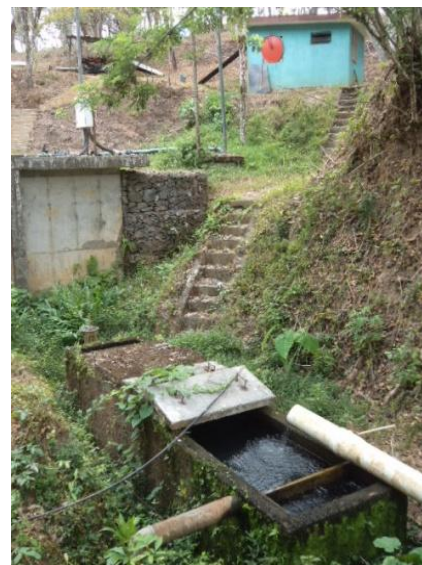
Figura 4. Presa ubicada en río San Miguel y Desarenador
