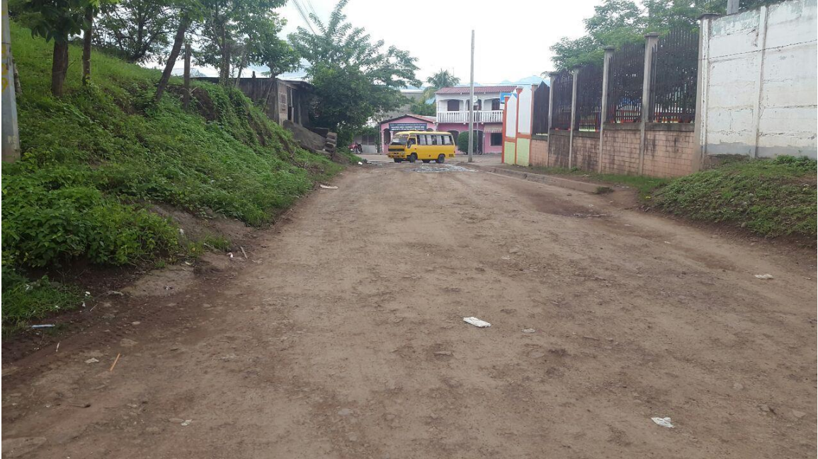
Fotografía 3. Entrada a la calle hacia el Rastro Municipal (Estación 0+080 A)
