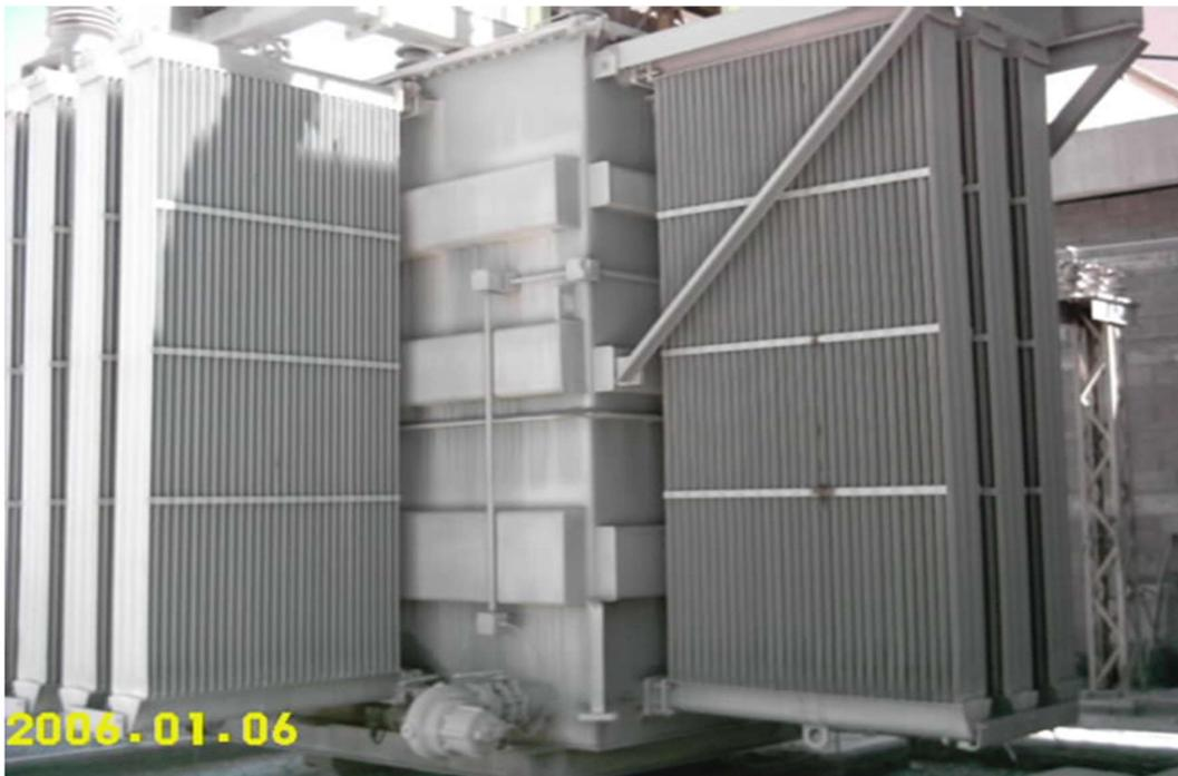
Ilustración 8. Radiador en transformador de potencia
