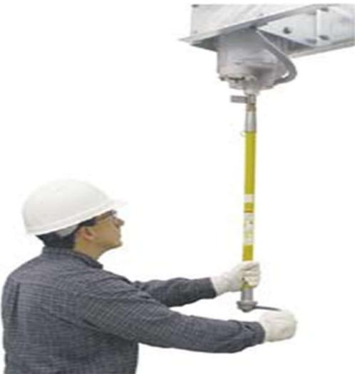
Ilustración 14. Instalación de un revelador de presión súbita en aceite
