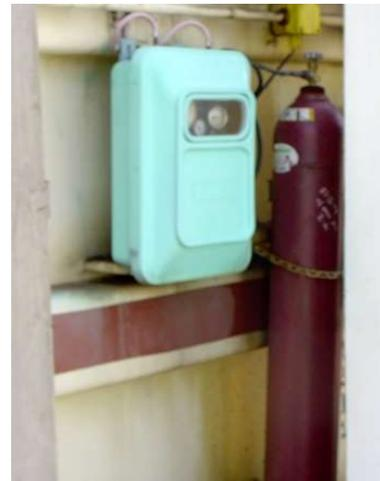
Ilustración 13. Válvulas y reguladores de presión que accionan el relé Buchholz con un tanque de gas inerte
