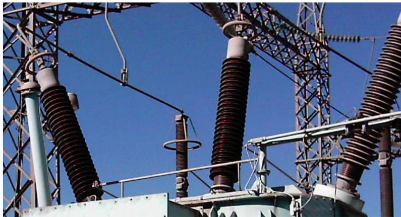
Ilustración 4. Bushings o boquillas
