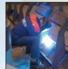
Montering av slagvogn til Tinfos Titan & Iron
