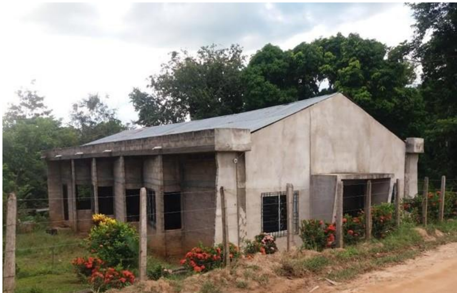
Fotografía 6. Iglesia Cristiana “Puente de Dios.
