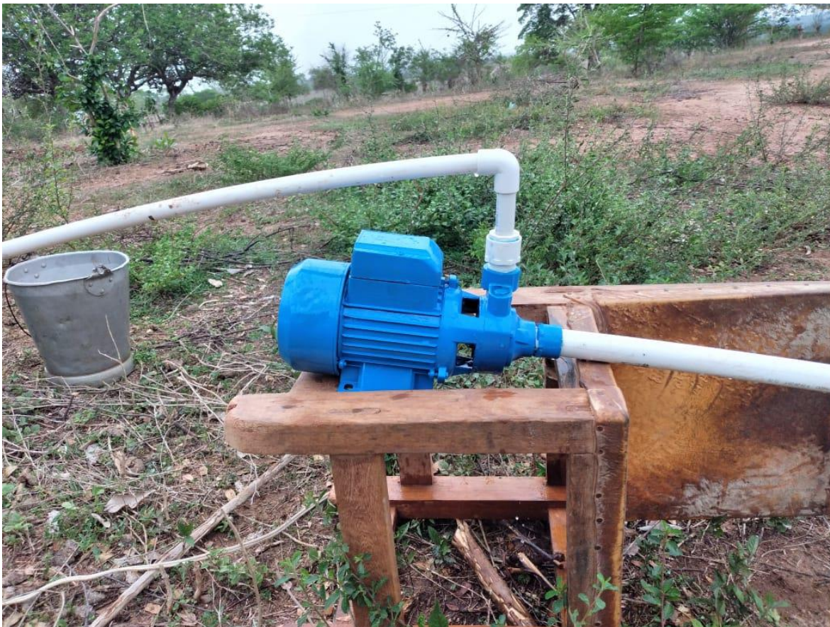
Ilustración 51 INSTALACION DE ELECTROBOMBA
