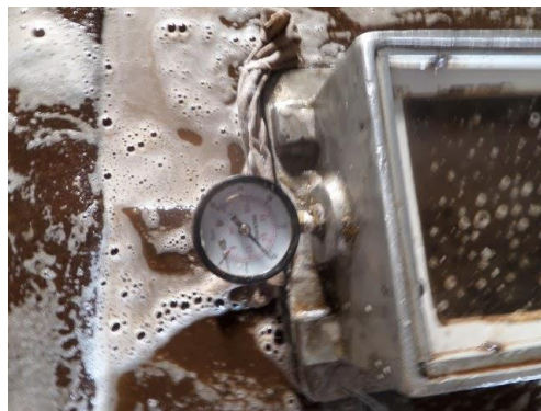
figura 13. Prueba con cámara de vacío (metal marine inspeccion, 2014)
