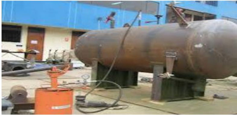
figura 5. Prueba hidrostática a tanque almacenador horizontal. (autores, 2019)
