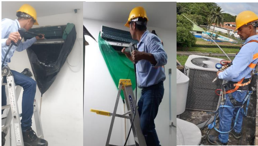
Figura 4. Ejecución del mantenimiento preventivo
