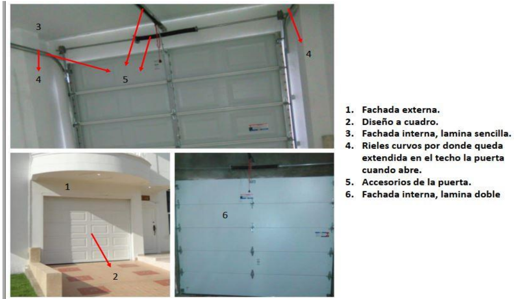
Figura 2-1. Puertas seccionales importadas, casa residencial.
