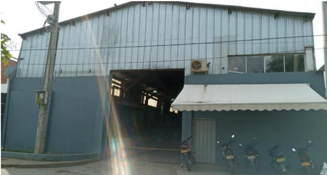
Figura 4-15. Planta de fabricación de la empresa Abrafelh ubicada en el barrio Sucre.
