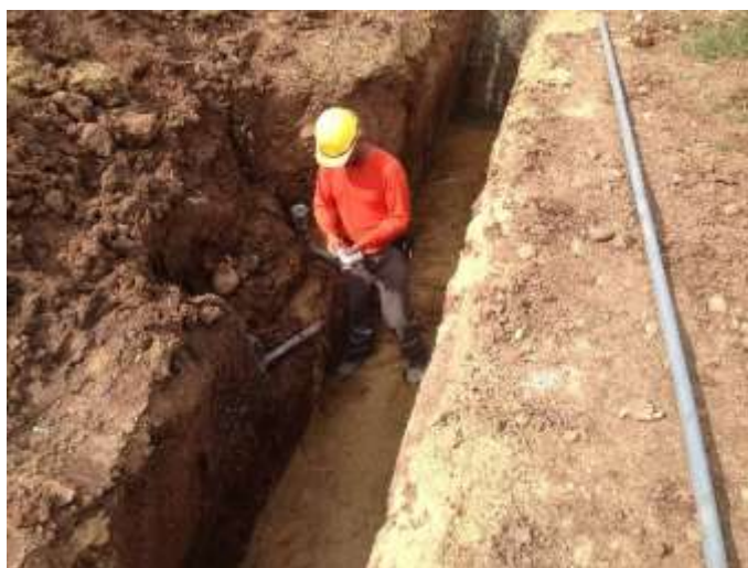
Figura 30. Reparación de tubería de agua. (Fuente: Elaboración propia - Durante trabajos en obra)
