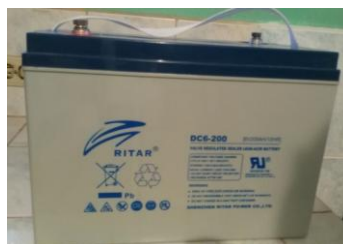
Figura 4.1 Banco de baterías Ritar RA 6-200Ah
