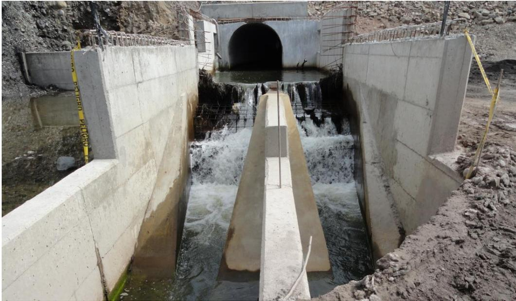
**Figura 3.4. Canal de captación a la salida de la Presa Chiquihurco.**
