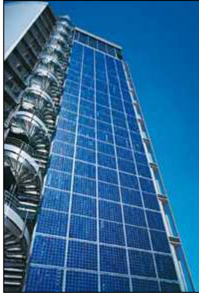
Figura 13. Edificio con fachada fotovoltaica
