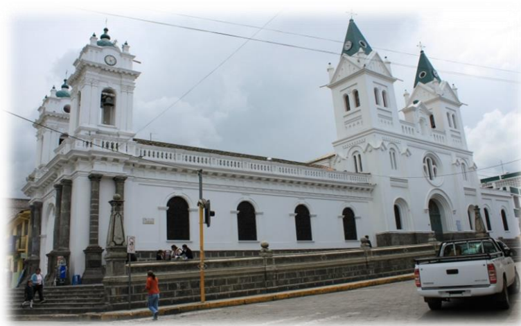
Figura 16: Iglesia Santiago de Machachi parte externa Fuente: Iglesia Santiago de Machachi; Elaborado por: Jaguaco & Manosalvas 2019
