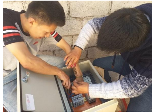
Anexo IV.4. Instalación del tablero de protección.
