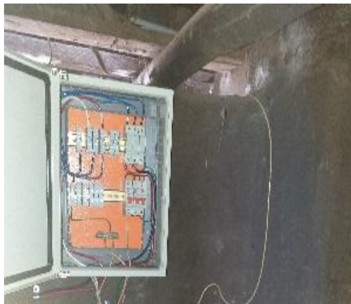
Anexo IV.4. Instalación del tablero de protección.
