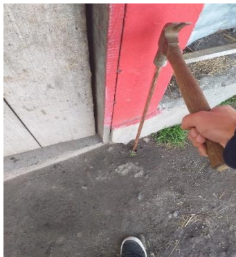
Anexo IV.2. Instalación de la puesta a tierra.
