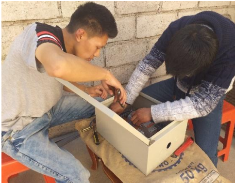
Anexo IV.4. Instalación del tablero de protección.
