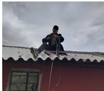
Anexo IV.2. Instalación de la puesta a tierra.
