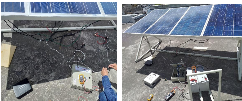
Anexo IV.1. Instalación de los paneles fotovoltaicos.
