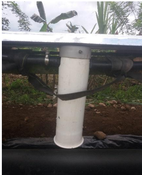
Figura 5.11. Válvula de seguridad.
