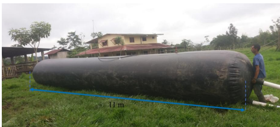
Figura 5.3. Longitud del biodigestor.
