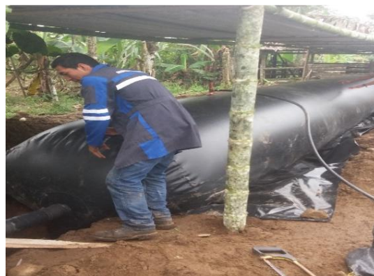
Figura 5.8. Biodigestor de geomembrana.
