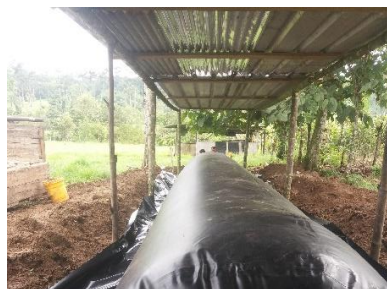
Figura 10. Cubierta de biodigestor.
