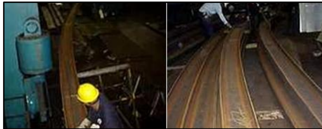
Anexo. Figura 3.2. Proceso de Rolado de Perfiles y tubería
